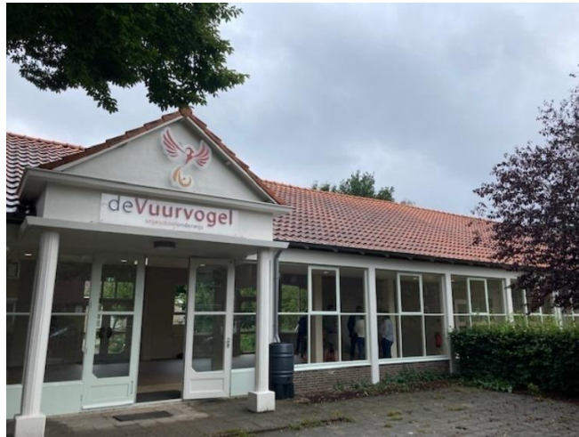
De Vuurvogel na de werkzaamheden
