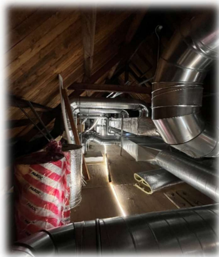
Werkzaamheden in de Meander
