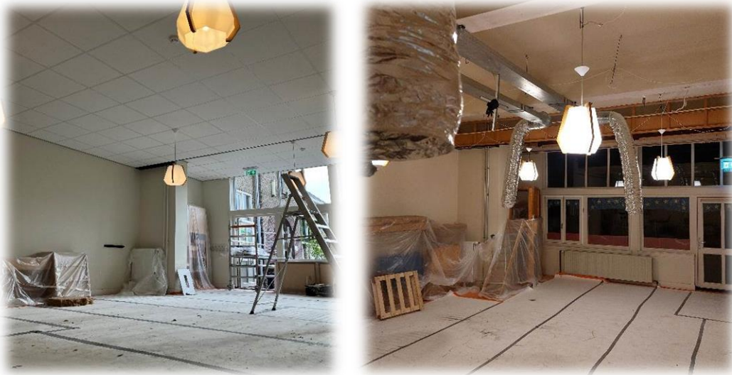
Werkzaamheden in Meander
